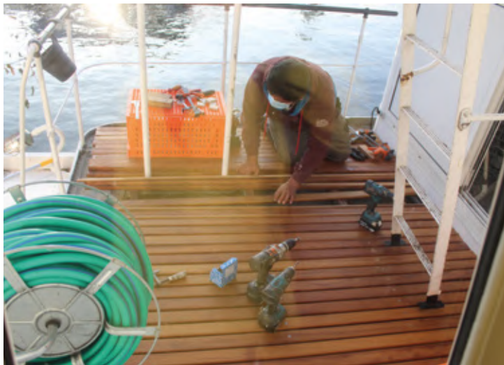
Des calibotis ont été installés
